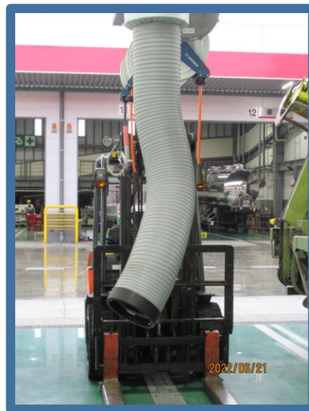
スポット空調（作業場所を冷やします）
